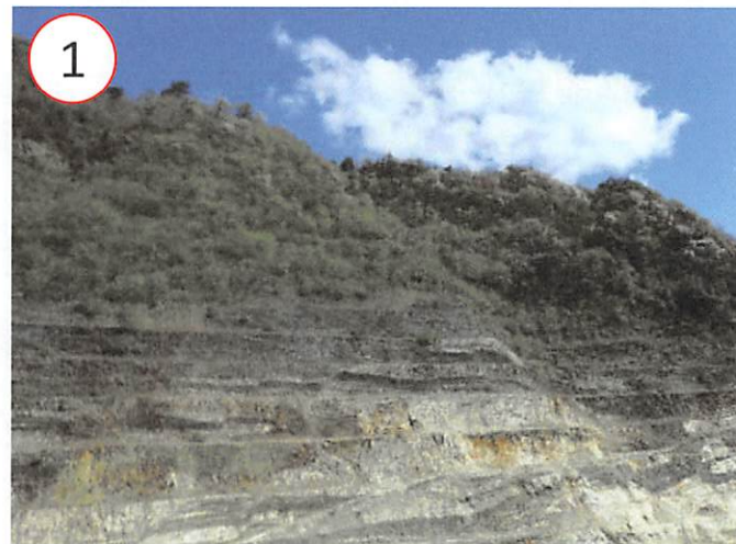
敷地内東側壁面を望む
