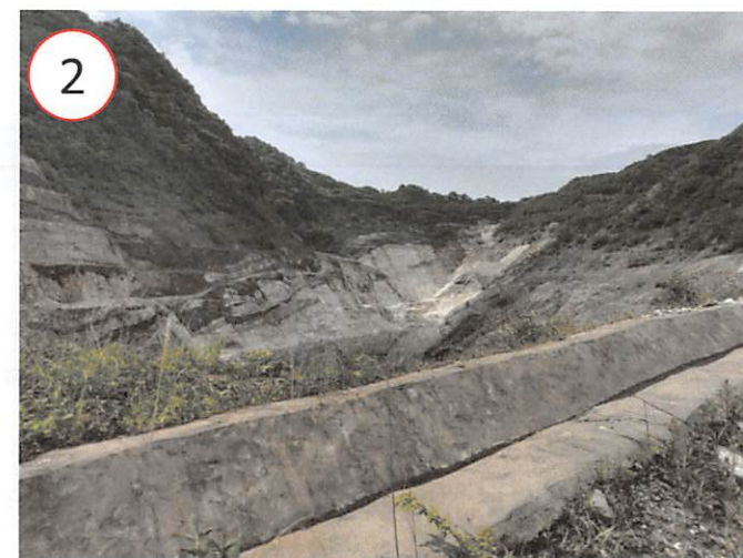
県道側から南を望む
