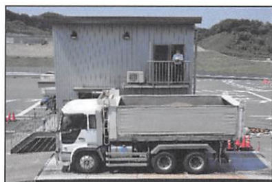
台貫による計量 廃棄物の目視検査
